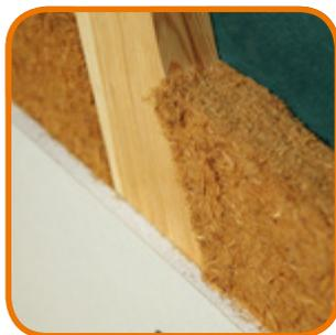
La laine de bois et les panneaux en fibre de bois sont fabriqués grâce au défibrage du bois.
